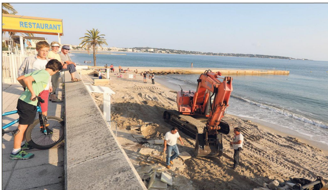
Débutés lundi, la démolition des plages du Midi n'est pas passée inaperçue.
